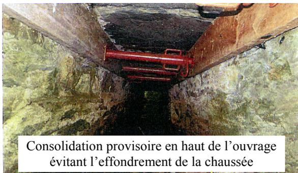
Consolidation provisoire en haut de l'ouvrage évitant l'effondrement de la chaussée
