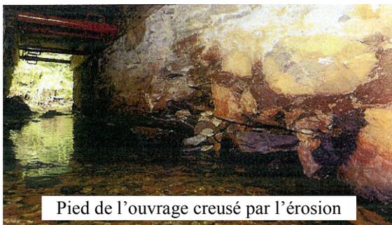
Pied de l'ouvrage creusé par l'érosion
