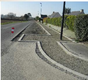
Un sentier piéton a été réalisé à droite en descendant et il est séparé de la route par une large bande enherbée permettant le ruissellement des eaux de pluie. Cette noue aura un impact visuel de rétrécissement de la chaussée pour le conducteur... qui lèvera sûrement le pied. Sur la partie basse, des barrières en bois ont été posées pour une meilleure protection des piétons.
