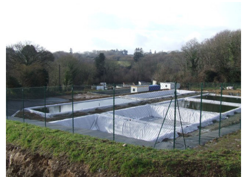
L'état d'avancement en mars 2015
